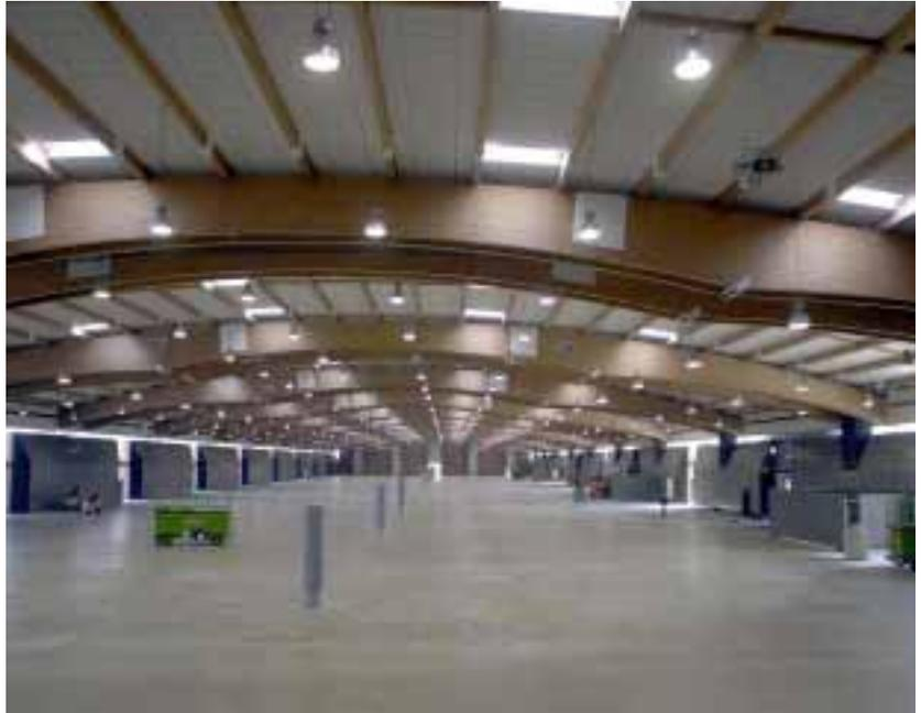
**La struttura si allunga in tutti i suoi 260 metri per 60 in campata unica; le grandi travi in lamellare sono state collaudate nei mesi scorsi: sono in grado di reggere fino a 300 quintali grazie all'innovativo sistema dei maxitiranti d'acciaio ancorati ai plinti e retti dai grandi pilastri d'acciaio. Legno, acciaio, vetro e calcestruzzo sono materiali scelti per garantire forza e leggerezza.**
