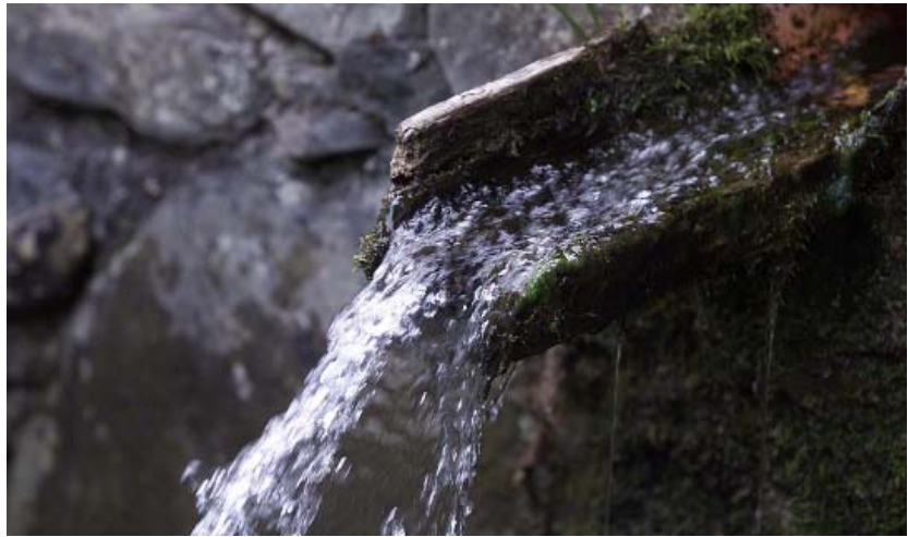
Le infiltrazioni rappresentano un "nemico" soprattutto per gli edifici storici
