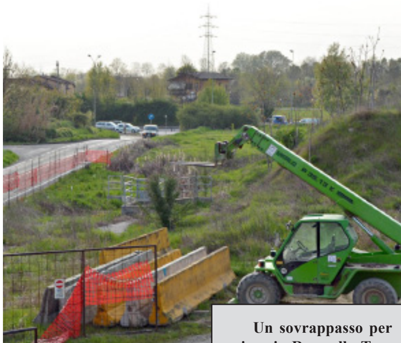
Il cantiere aperto in via Rose. L'operazione dovrebbe alleggerire il traffico su via Milano
